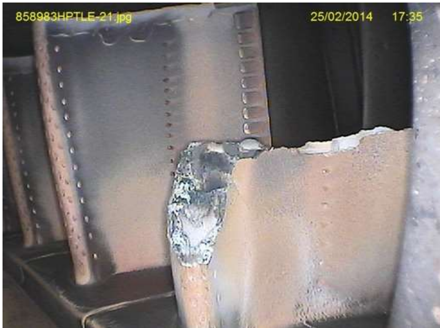
Ailette de turbine cassée
